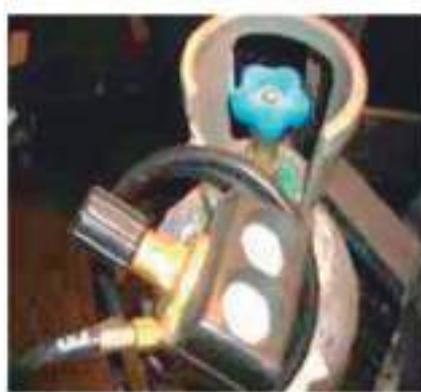
*Las botellas de CO<sub>2</sub> deben disponer de las protecciones de la válvula y en el lugar de uso, de la ficha de seguridad*
