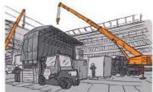
*“En particular, si una carga tiene que ser elevada simultáneamente por dos o más equipos de trabajo para la elevación de cargas no guiadas, por ejemplo, dos grúas elevando la misma carga, deberá elaborarse y aplicarse un procedimiento de trabajo”. Anexo II de la Guía Técnica del R.D. 1215/1997.*
